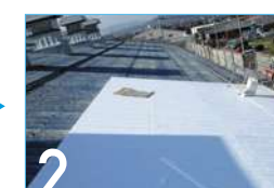
2 EPSカバー材敷設 既存の屋根にEPSカバー材を貼付け。
