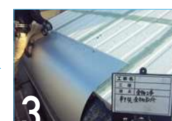
3 エッジカバー取付け 屋根端部、金物取付け。
